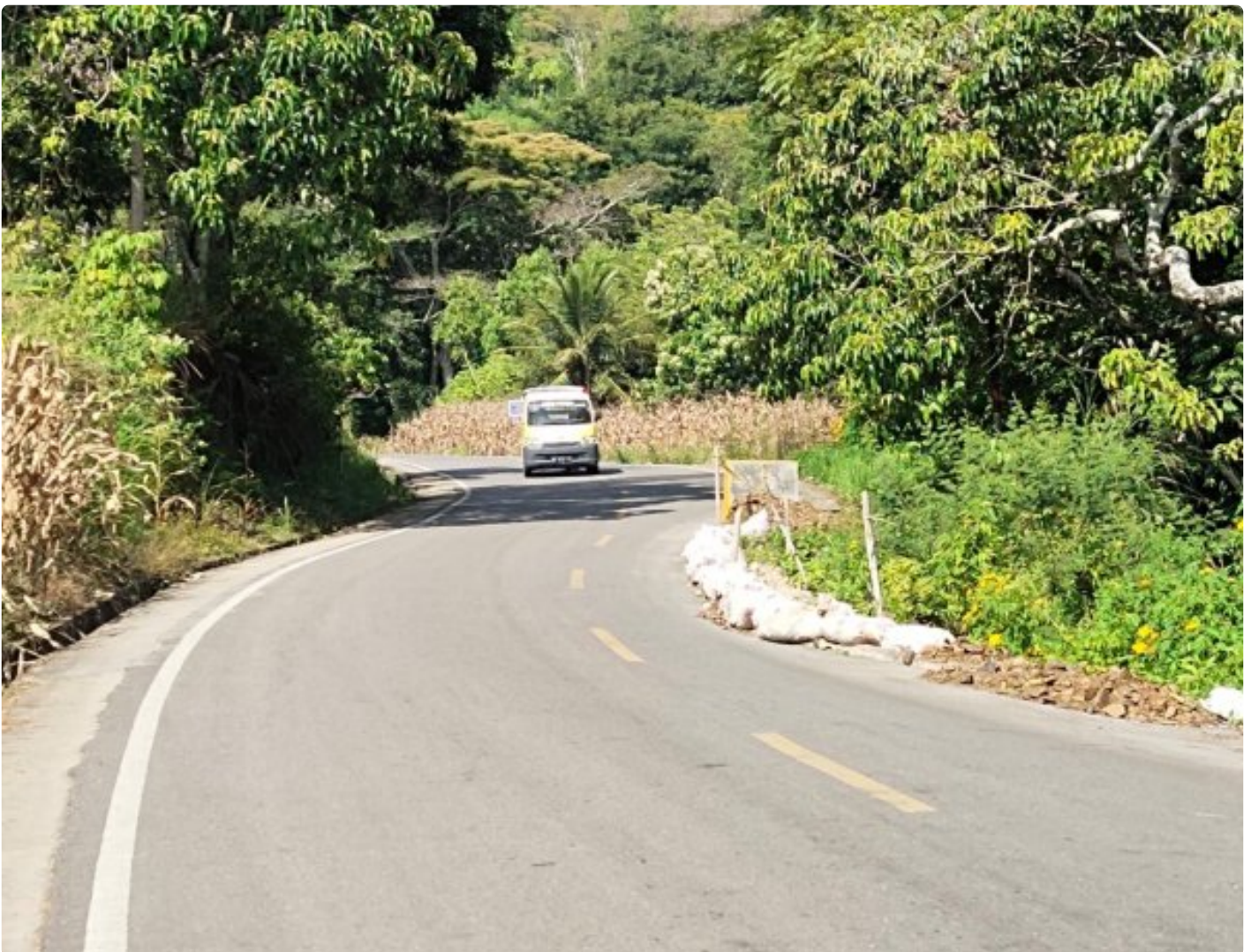
Bdan Jalan Amblas di Jalinsum Tomok-Pangururan Desa Marlumba Kecamatan Simanindo
